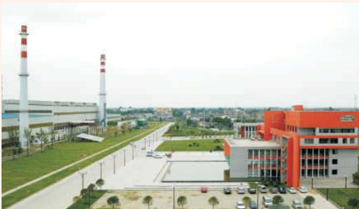
▲ 攀钢集团成都钢钒有限公司厂区
