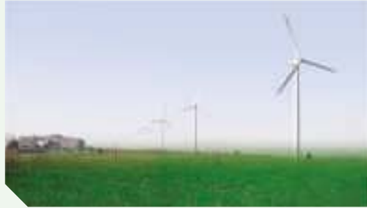
▲ 鞍钢鲅鱼圈钢铁基地风力发电项目
